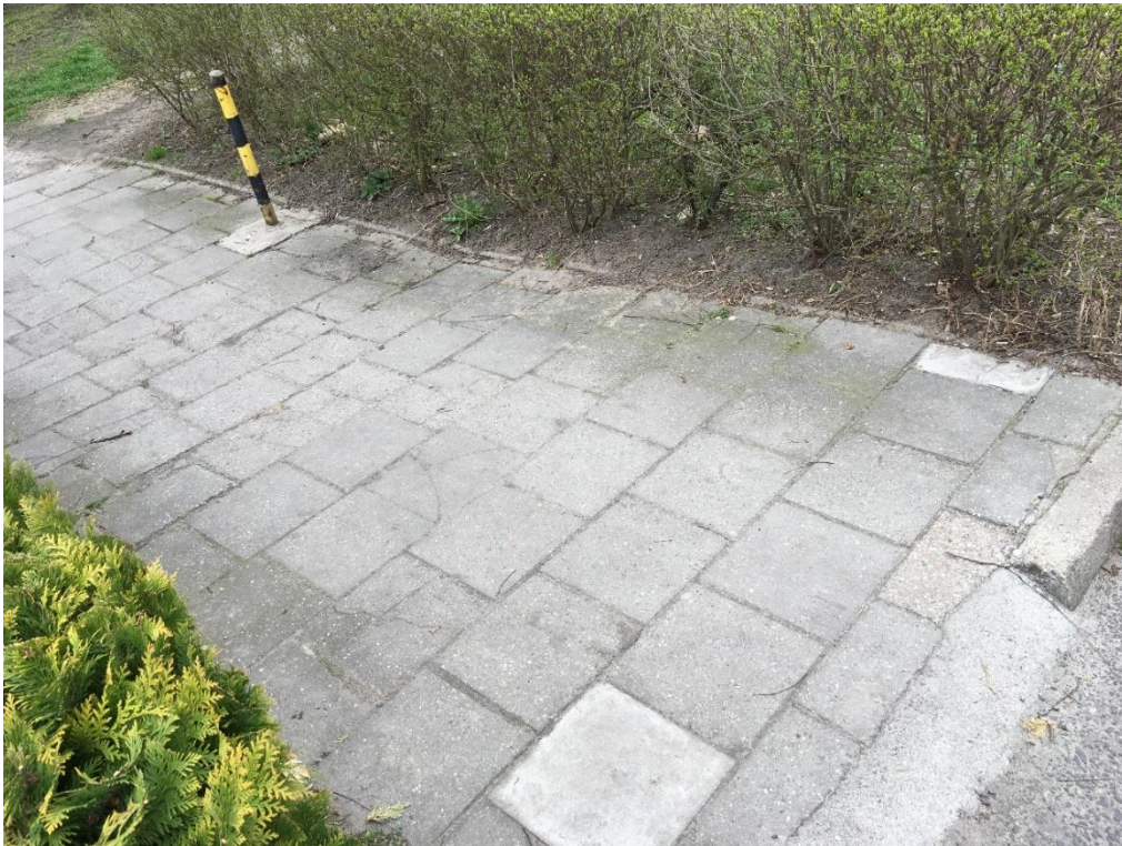
Rysunek 4 - chodnik prowadzący w kierunku bloków przy ul. Ligockiej - stan istniejący
